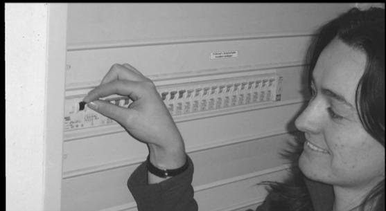
Überprüfen Sie die Funktion der FI-Schalter in Ihrem Sicherungskasten. Dies ist ein wichtiger Schritt zur Sicherheit.
